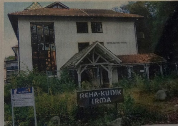
Die leer stehende ehemalige Klinik Irma soll abgerissen und durch ein Geschäfts- und Wohnbauprojekt ersetzt werden. Foto: H.-J. Eisenmann
