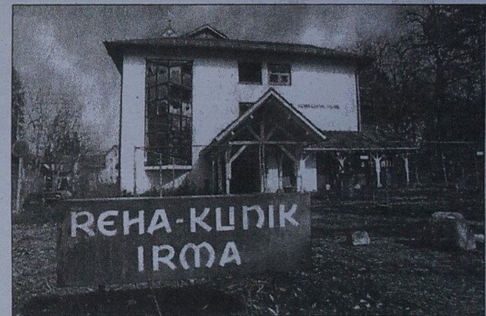
Eingeschlagene Fenster und Schäden am Dach der ehemaligen Irma-Klinik sind vielen Bürgern ein Dorn im Auge. Foto: Archiv
