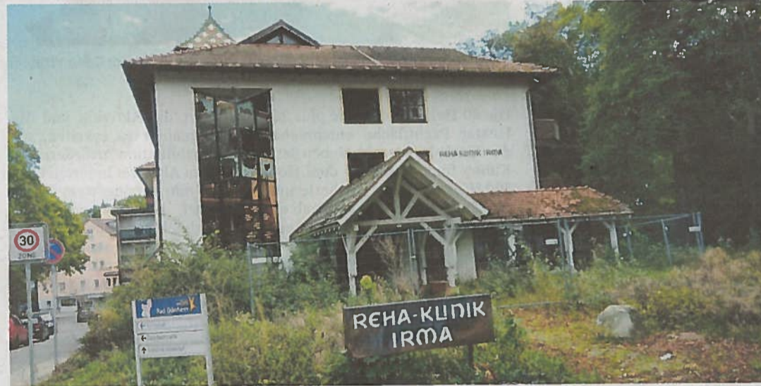
Der vom Architekturbüro geplante vordere Baukörper mit vier Geschossen und einem nach hinten gerückten Penthousegeschoss und dem Platz Richtung Hindenburgpark. Unten der Altbau an der Ecke Luisen- und Hofstraße, der bereits von Pflanzen umrankt ist. Fotos: Rebholz/Eisenmann
