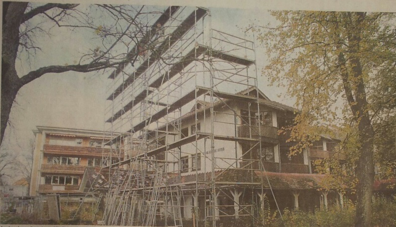
An der ehemaligen Irma-Klinik wurde ein Schauergerüst aufgestellt, das den Bürgern heute die Dimension des Neubaus zeigen soll.
