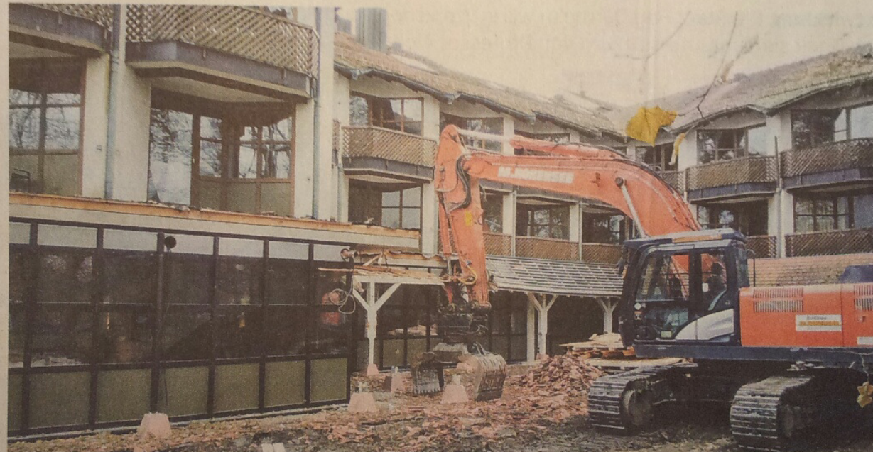
Die Abrissarbeiten an der ehemaligen Rehaklinik Irma haben begonnen.
