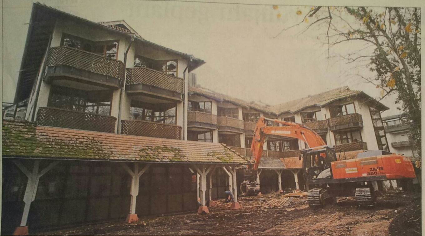
Vorbereitende Arbeiten zum Abriss der ehemaligen Rehaklinik Irma haben begonnen. Das Gebäude soll dann voraussichtlich ab Mitte nächster Woche abgerissen werden. Fotos: Reutter
