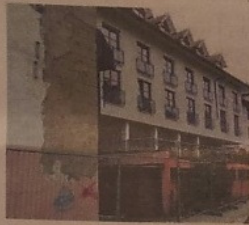
Die leerstehende ehemalige Klinik Irma wird gerade abgerissen.
