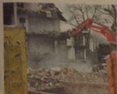
Die ehemalige Rehaklinik Irma wird abgerissen. Foto: Eisenmann
