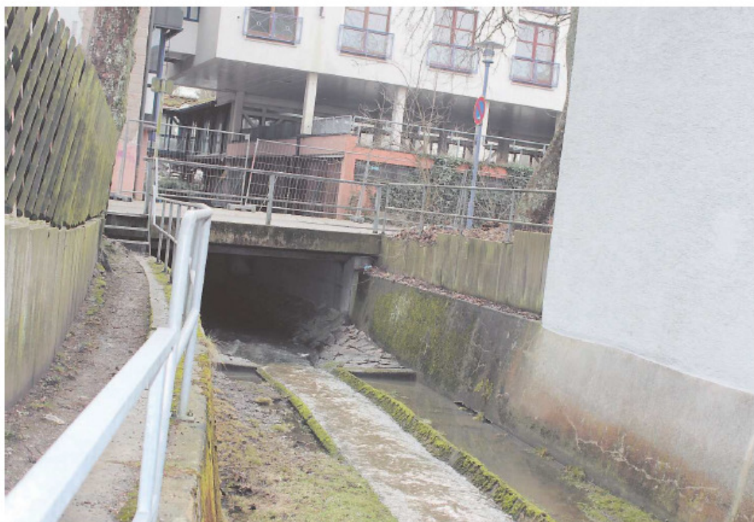
Die Stille Musel fließt quer durch die Bad Dürrheimer Innenstadt, entlang der Friedrichstraße, und verschwindet auf Höhe des Café Walz dann hinter der Bebauung. An der Hofstraße stößt sie auf die ehemalige Irma-Klinik und verschwindet wieder in der Verdolung. Foto: H.-J. Eisenmann
