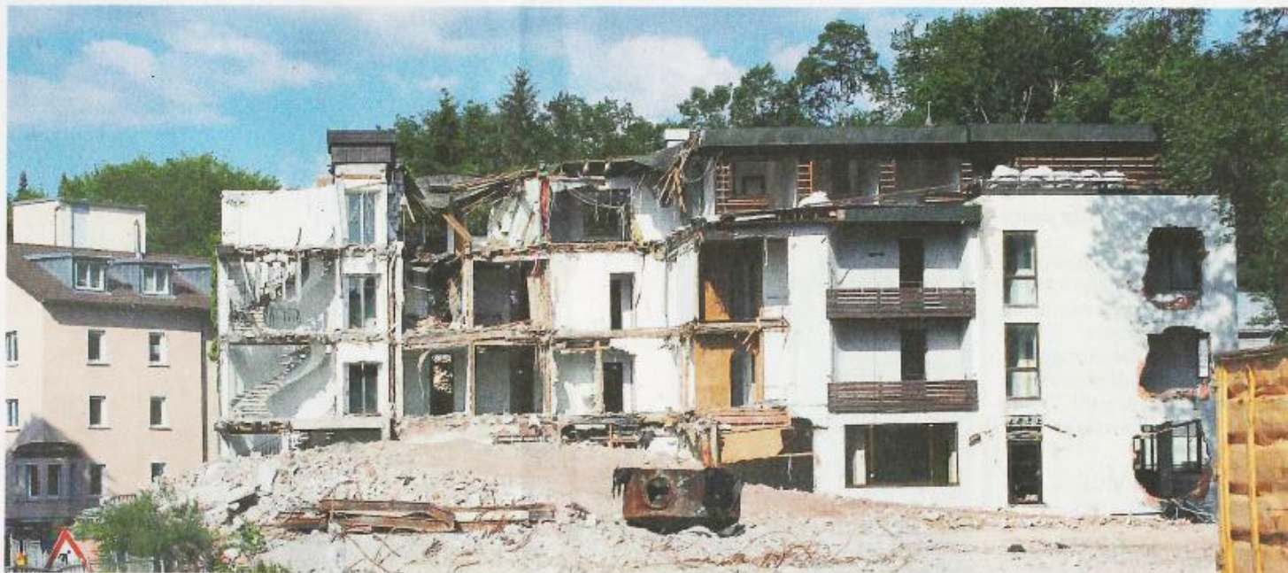
Hier bewegt sich seit Wochen nichts: Die Abrissbaustelle Irma im Zentrum der Kurstadt.
